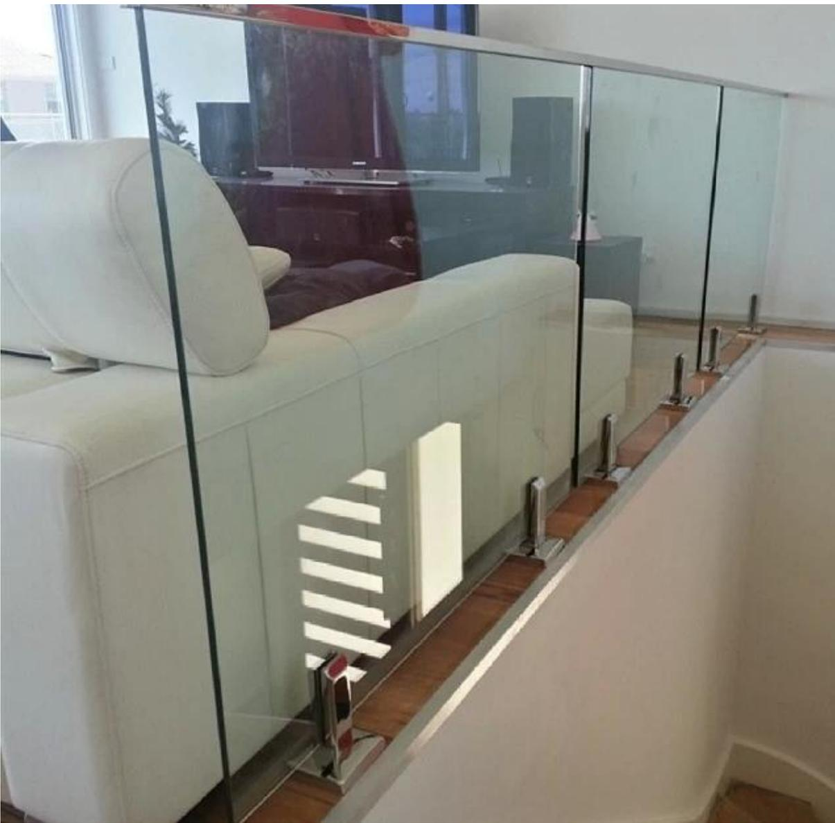
3. 25 x 21mm geschlitzte Edelstahlrohrhandlaufsicherheit
