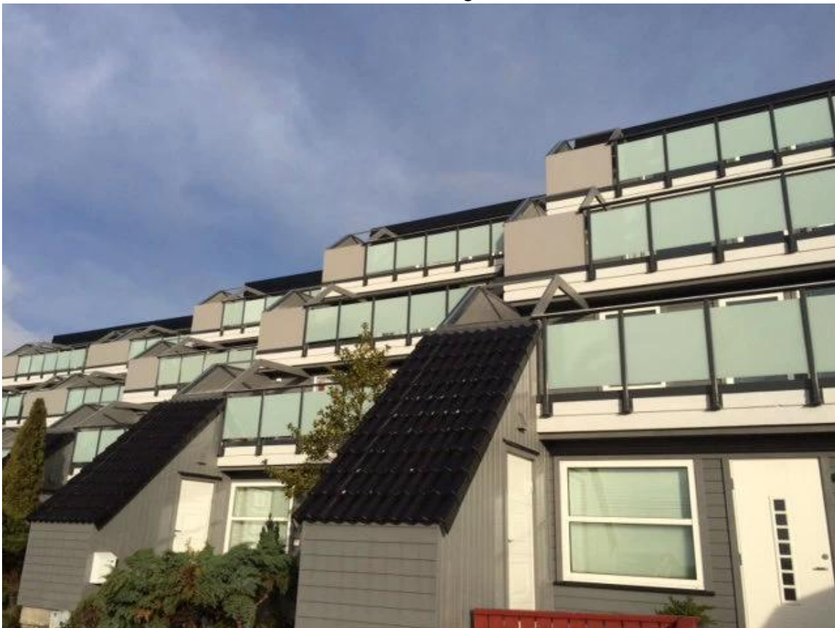
Seitlich montierte Alu-Handlaufbahn in Norwegen
