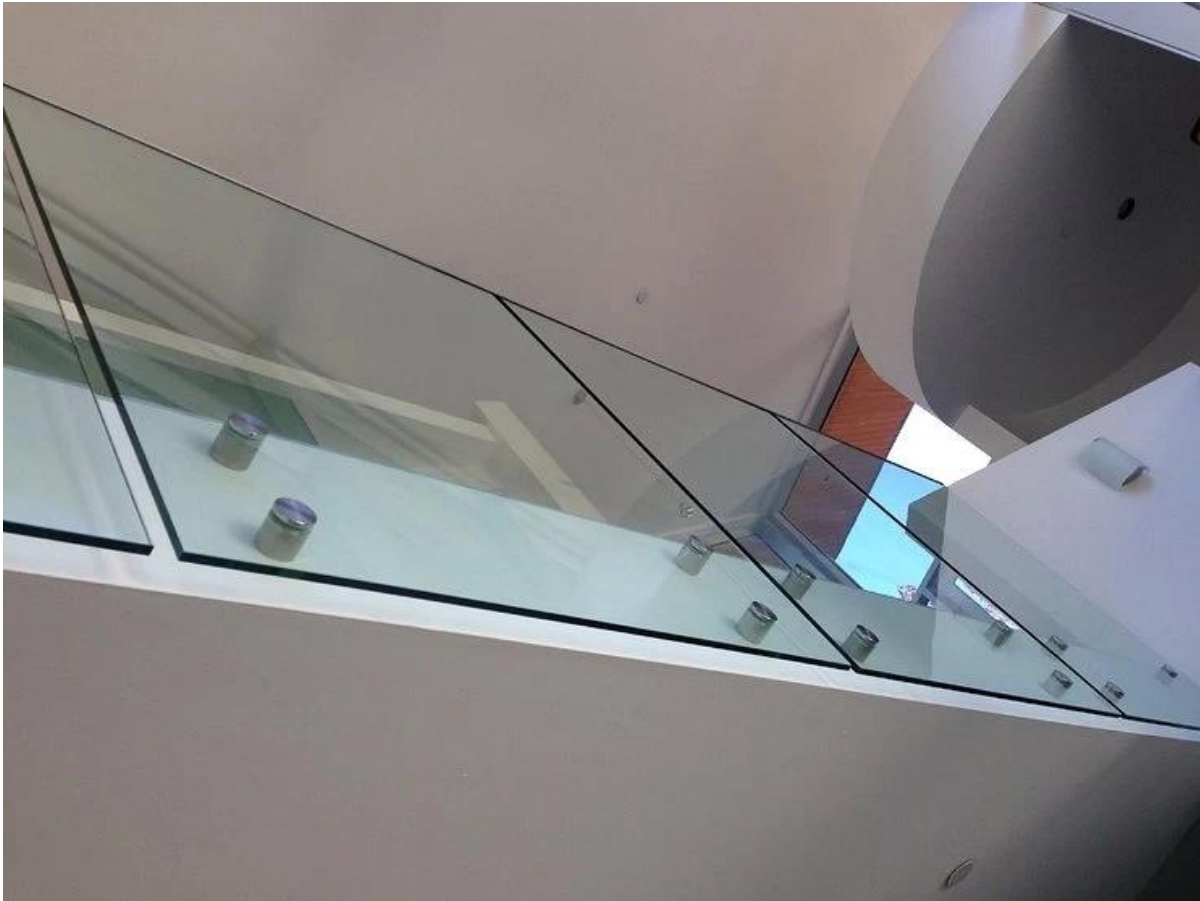
Abstandshalter aus Edelstahl, Halterung für Glaspaneele, Geländer-Design
