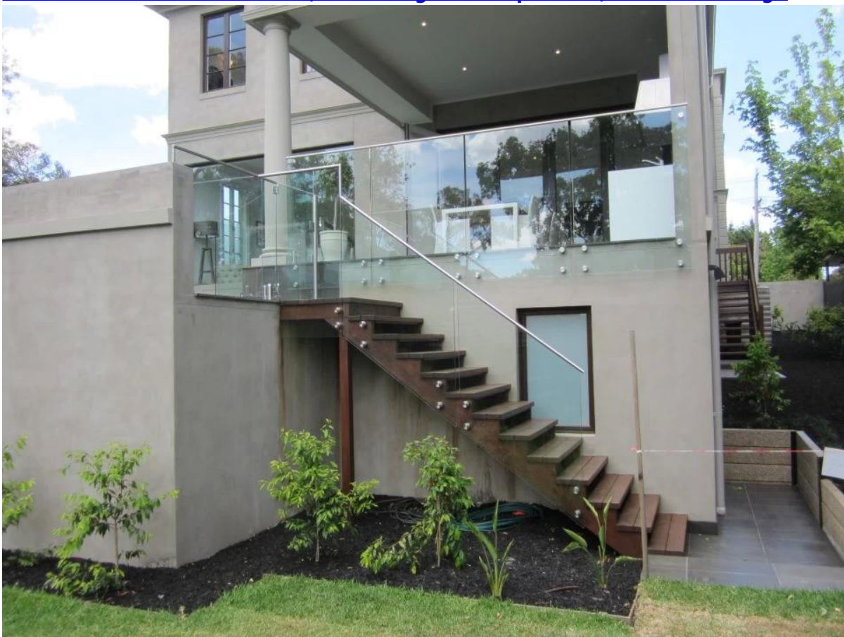
Abstandshalter aus Edelstahl, Halterung für Glaspaneele, Geländer-Design
