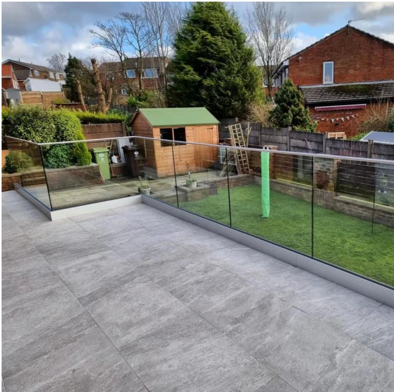
**Rahmenlose Balustradenschiene Aluminium-U-Kanal-Glasgeländer-Hardware**
