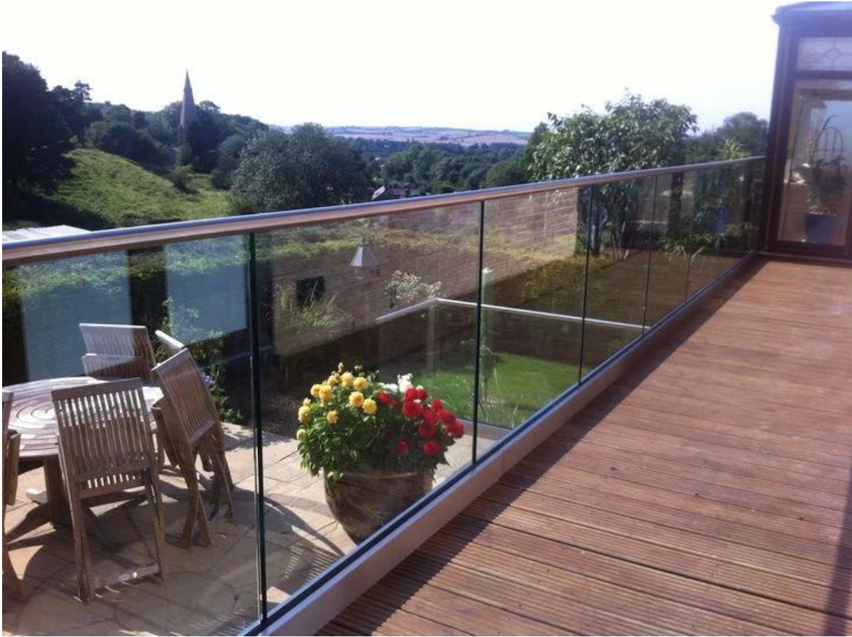
U-Aluminiumkanal + 10-12mm gehärtetem Glas-design
