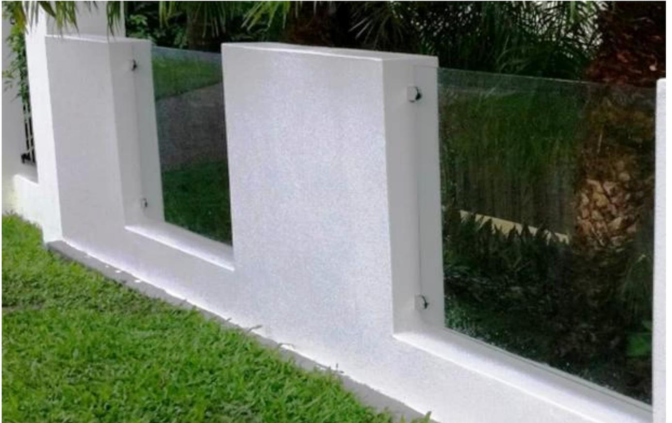
Die Glasgelnderklemme wird normalerweise mit Edelstahlpfosten zum Halten von Glasscheiben verwendet.
