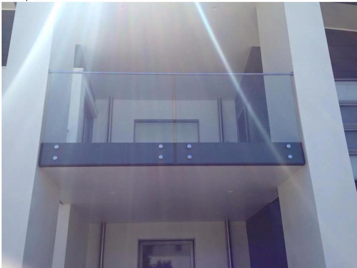
Steckplatz Rohr Handlauf wird am oberen Rand Glas-Zaun, die Ihre rahmenlose, halb rahmenlosen Glas-Geländer mehr gleichmäßiger und stärker zu machen, und schützen Sie mit der hand.
