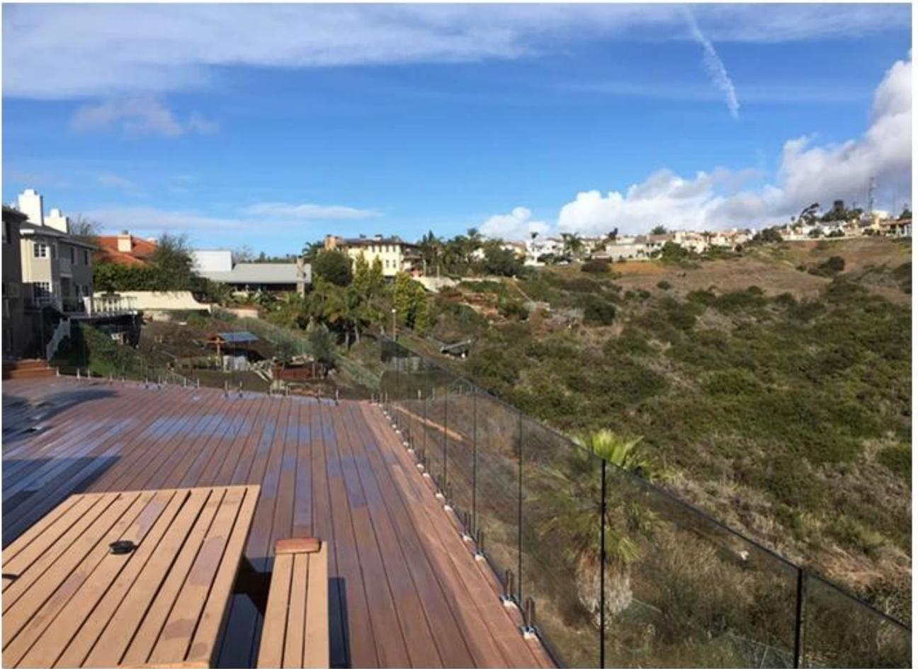
**Seitlich montiertes Glaszapfen-Design für rahmenlose Balkon Geländer:**
