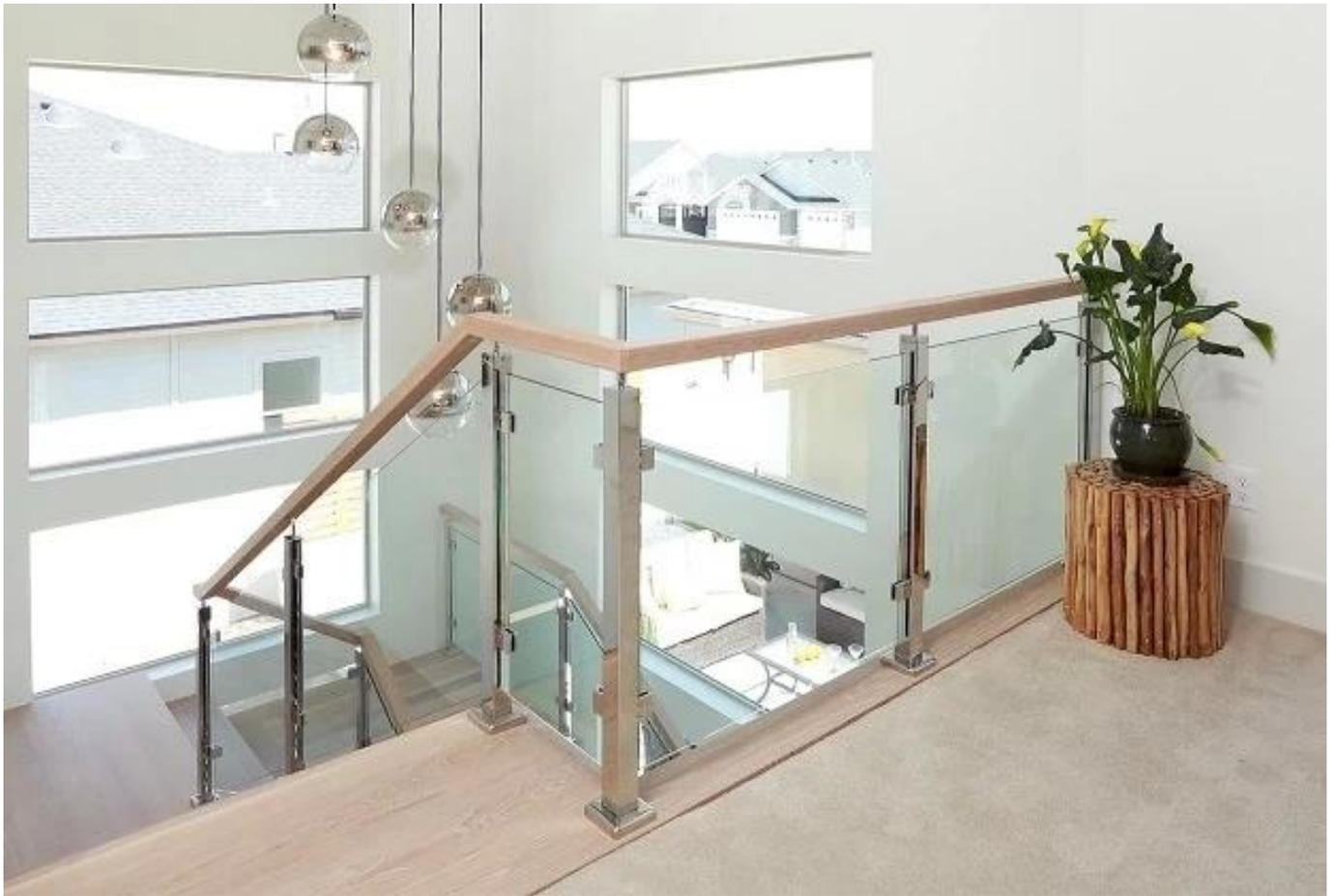
Die Glas Geländer Klemme, die normalerweise mit Edelstahlposten verwendet wird, um Glasscheiben zu halten, für Balkongeländer, Terrassengeländer, Treppen. Geeignet für den Innen- und Außenbereich.
