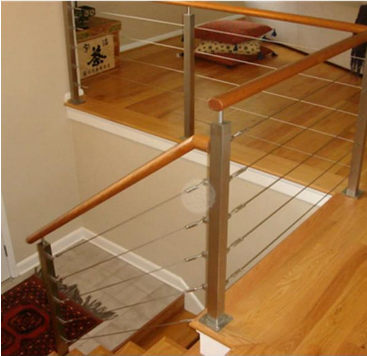
4. für Balkontreppe und Balkon verwendet
