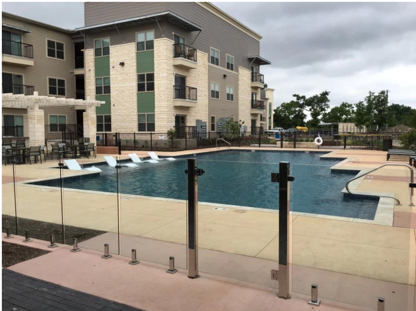
80x80mm quadratischer Edelstahlposten mit Handlaufdesign für handelsübliches sicheres Glasgeländer
