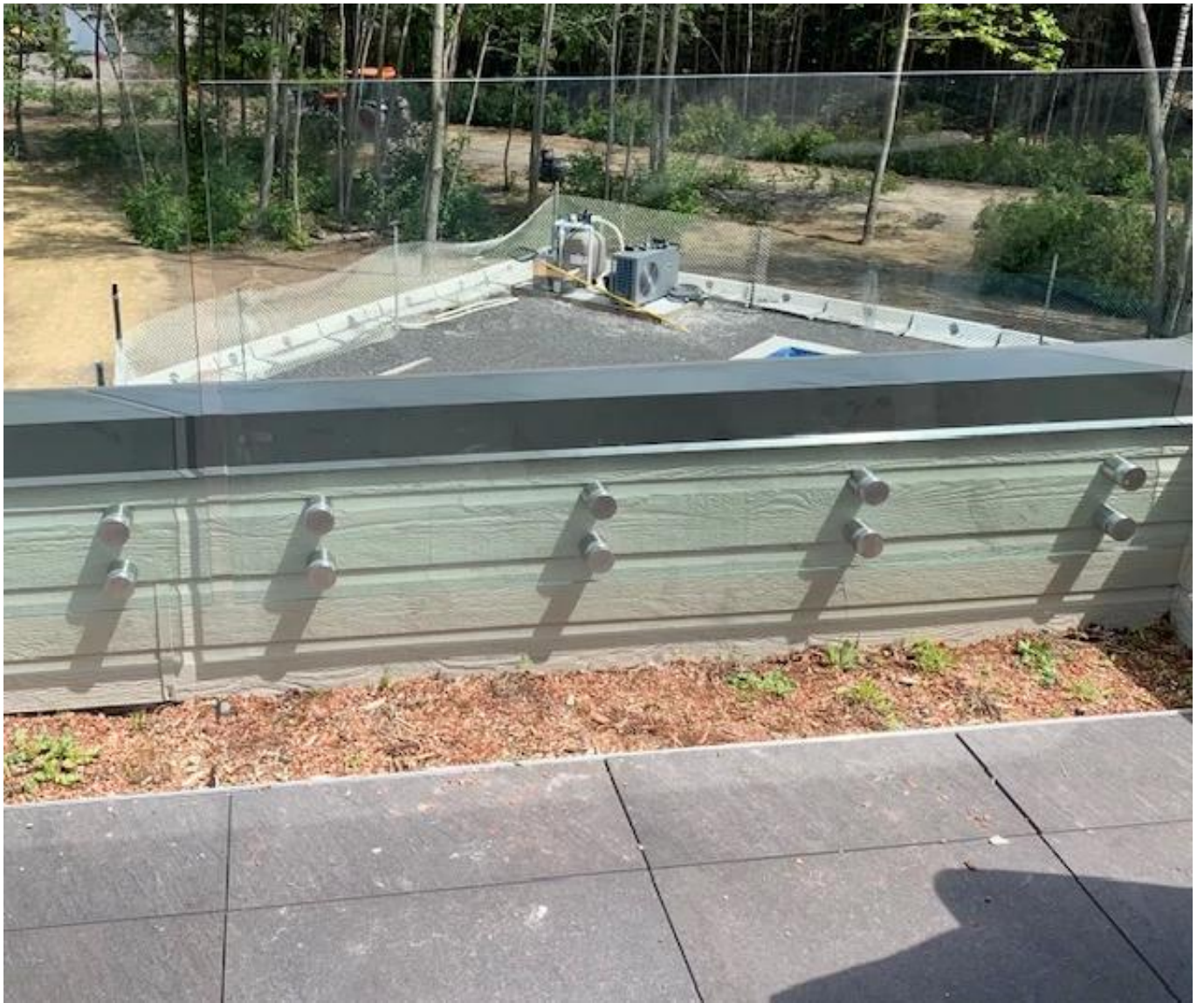
Abstandshalter aus Edelstahlglas für rahmenlose Glasbalustraden
