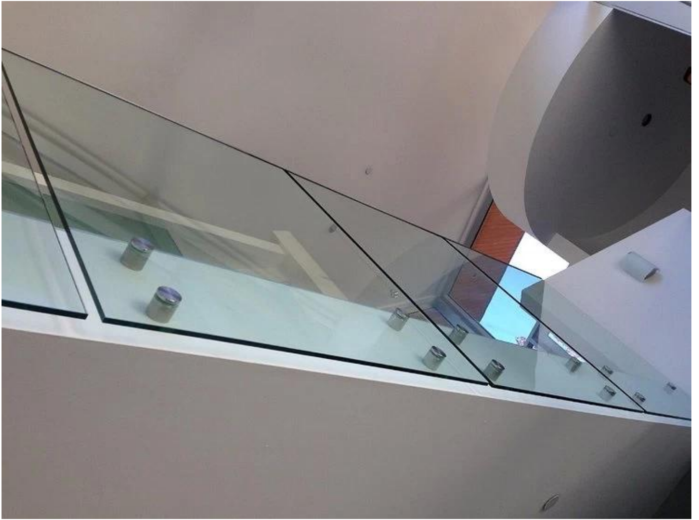
Abstandhalter aus Edelstahl, Halterung für Glasscheiben, Geländerdesign
