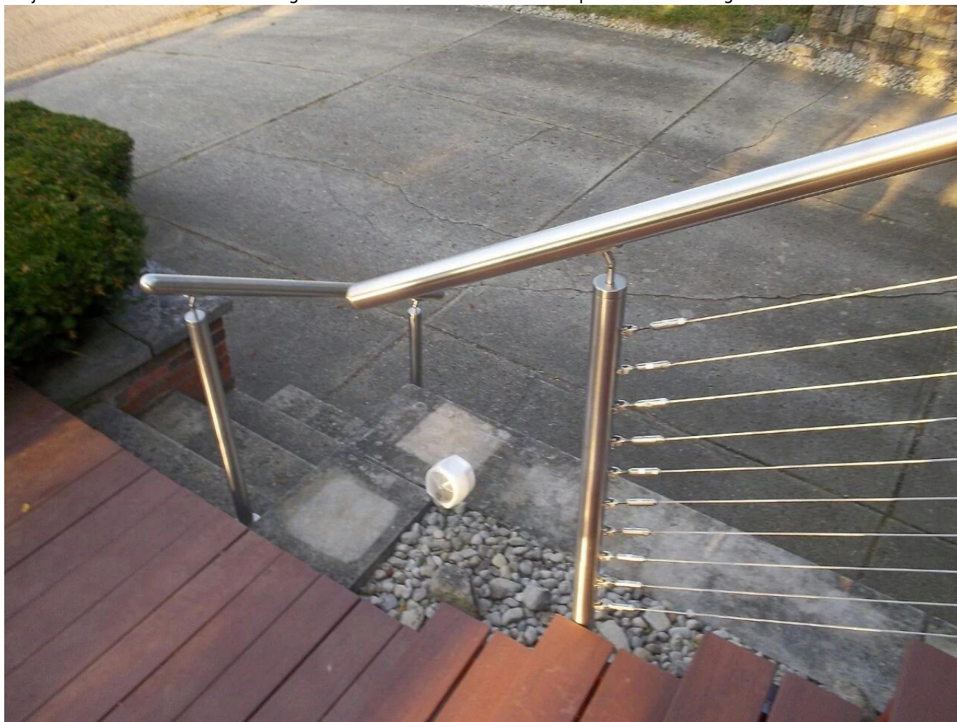
Projektfotos von Drahtseilbrüstungen mit T803 Drahtseil Gewinde-Spannschloss Swageless-
