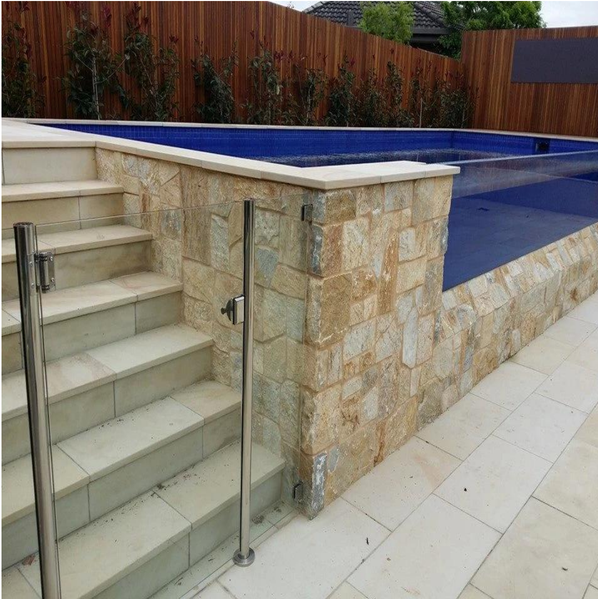
Position: Brücke Geländer / Geländer, Dachreling / Geländer, Veranda Geländer / Geländer, Treppen Geländer / Geländer
