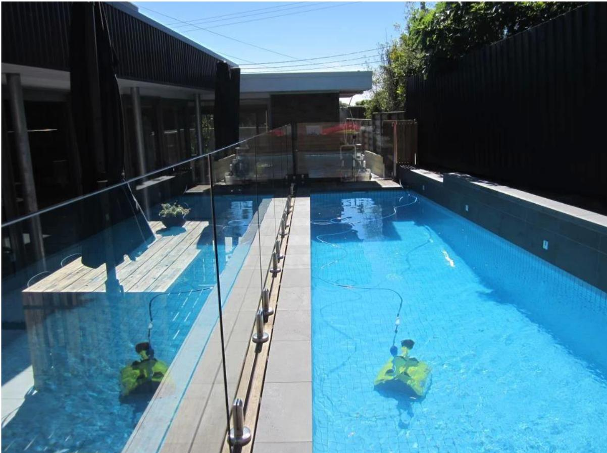
Glasgeländersystem, rahmenlose Glasgeländersystem, framless Glasgeländer mit Edelstahlstützen und gehärtetem Glas
