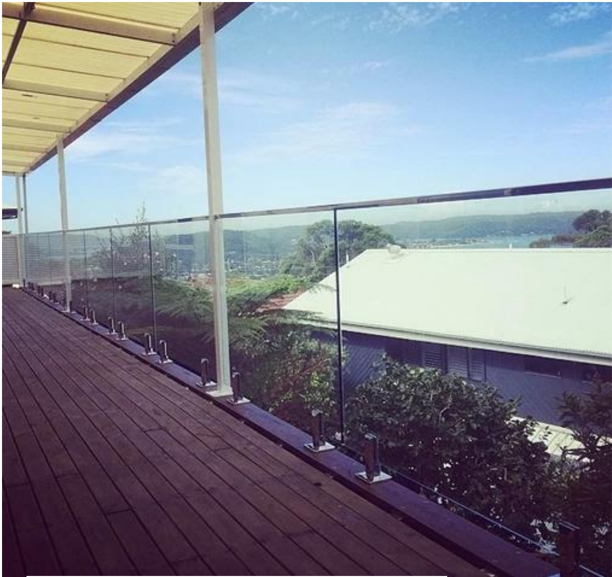
2). Edelstahl oberen Schienen Außenterrasse Glas Geländer:
