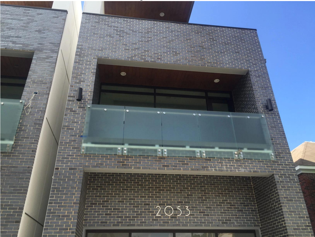
Installationsfotos der Geländerhalterung aus Glas
