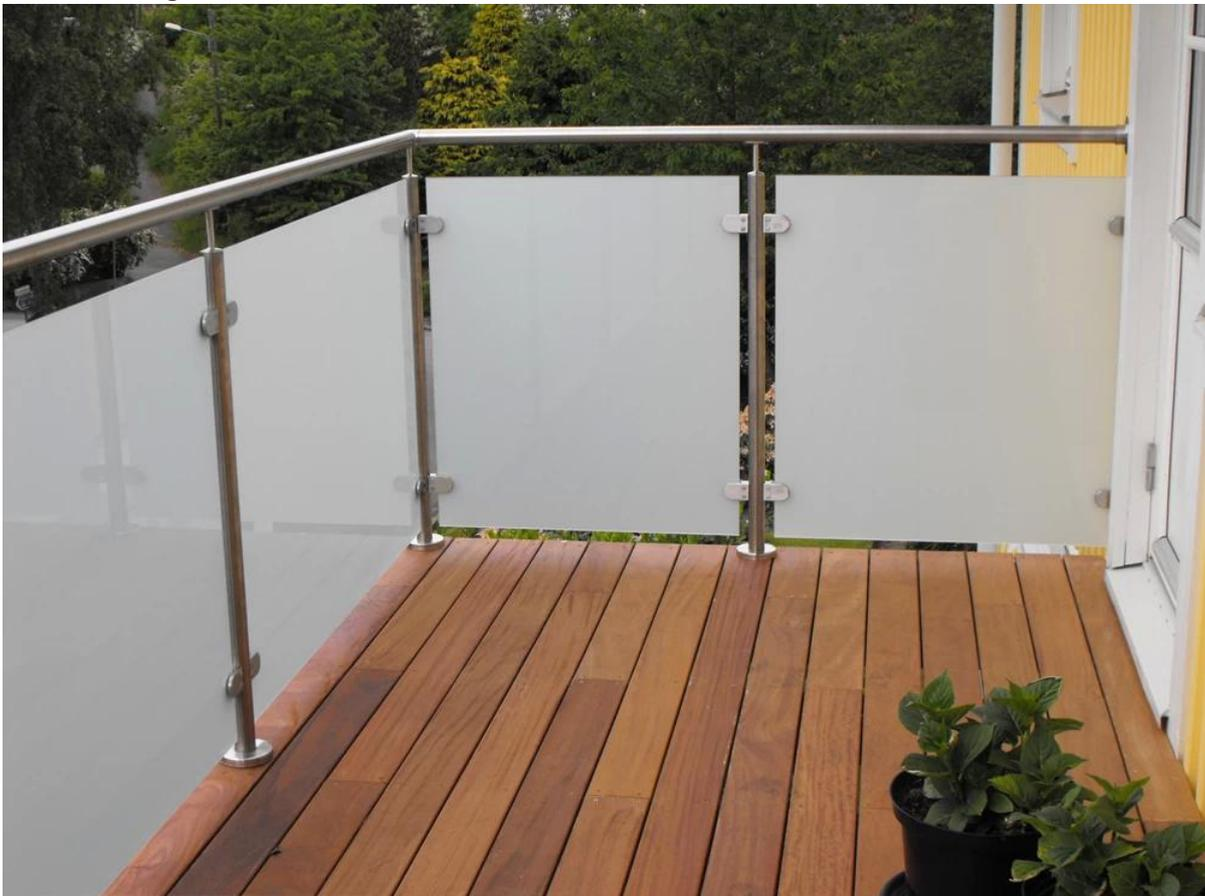
2) Rahmen draussen Edelstahl Balustraden Geländer Deck mit gehärtetem Glas
