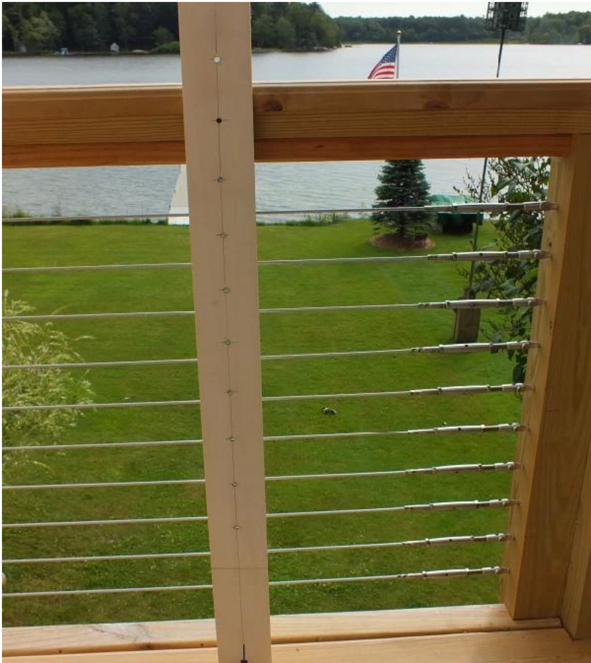
Kabel Relingsystem Geländer Innen- / Außentreppe auf das Projekt Treppenhaus:
