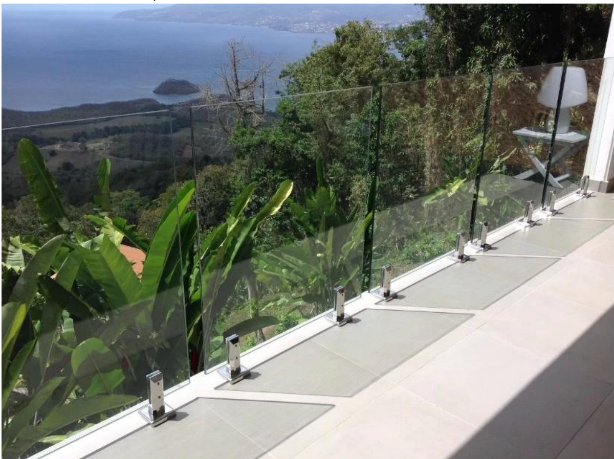
Zapfen ist weit verbreitet als Glas-Zaun Panel-Support unten, Holz, Beton, Stahl Stock Balkon, Deck, Schwimmbad Zaun installiert.
