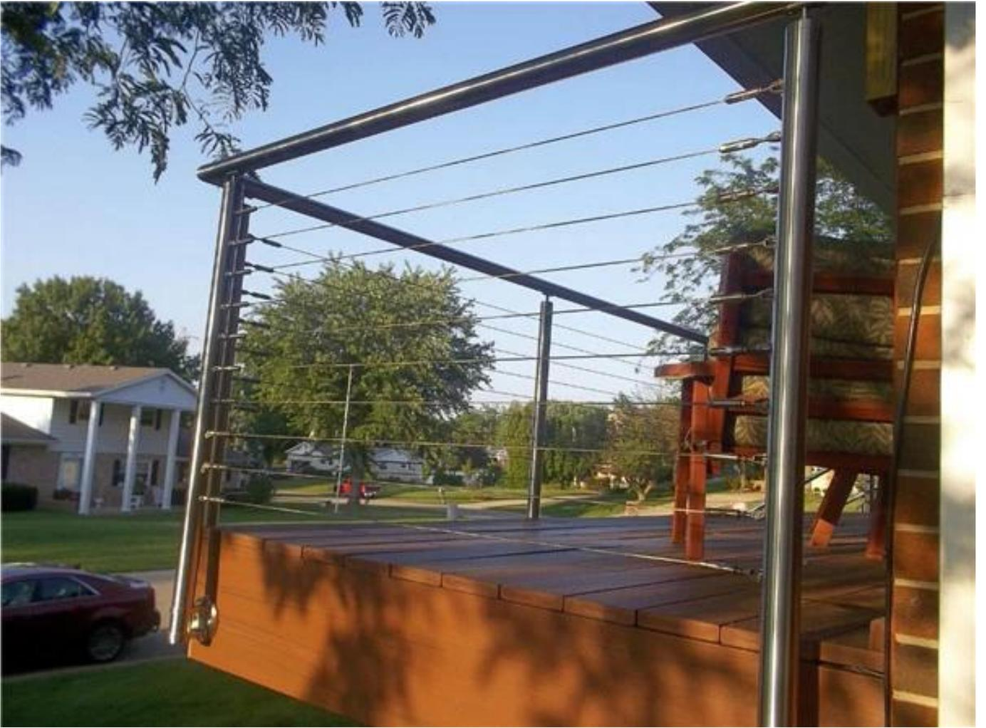
Kabelverschraubung: T803 (für 3-5mm Kabeldraht)
