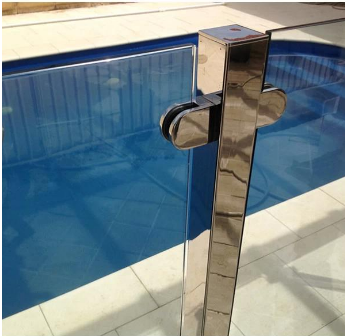
5.Installation Führer für Glasklemm
