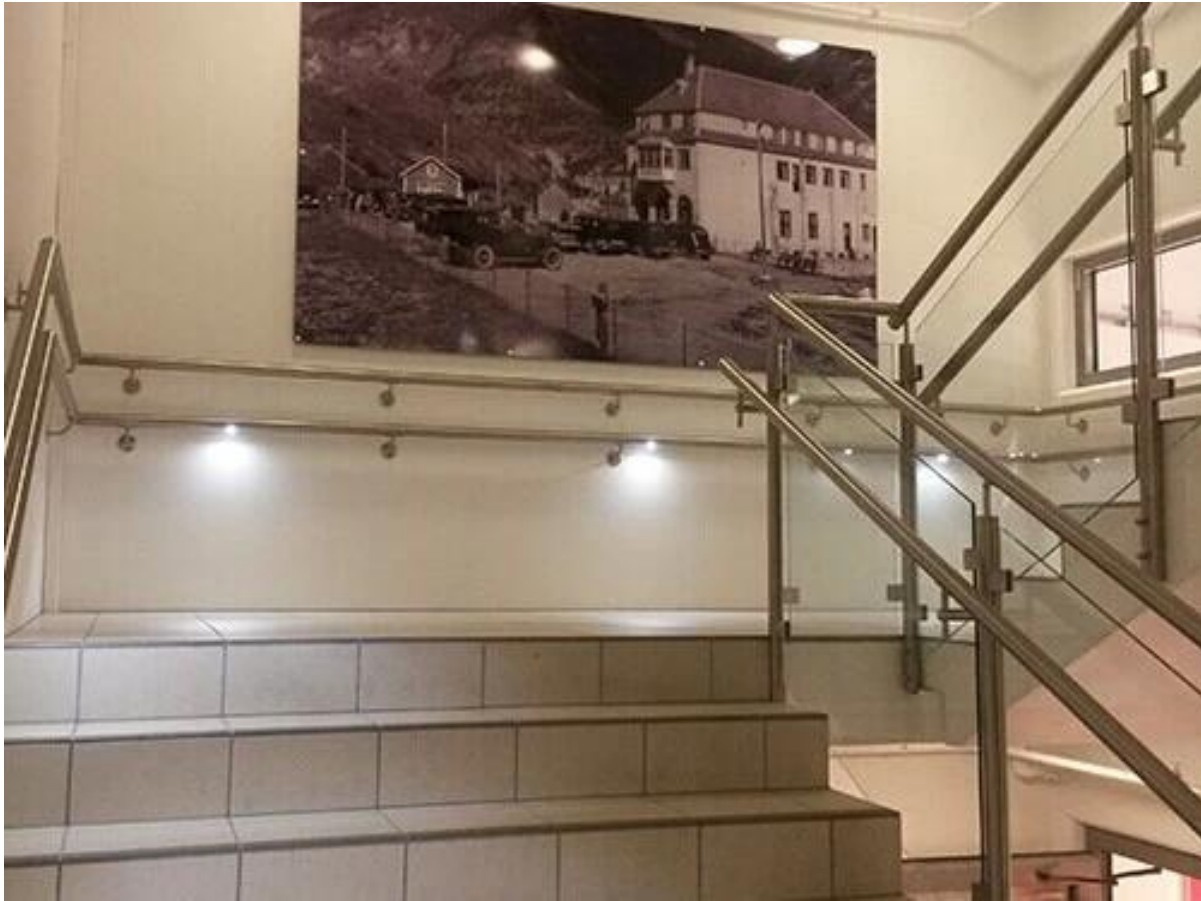
Rundrohr-Anschluss an Edelstahl-Treppe Handlauf verwendet
