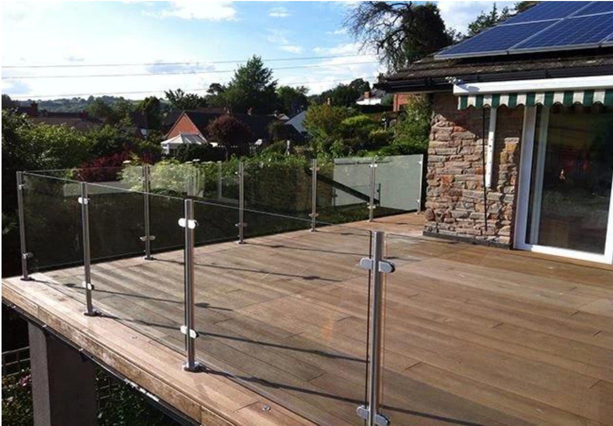
4. Außen Edelstahl Balustraden Handläufe Glasklemmbeschläge. javascript: void (0); /* 1468919934213 */
