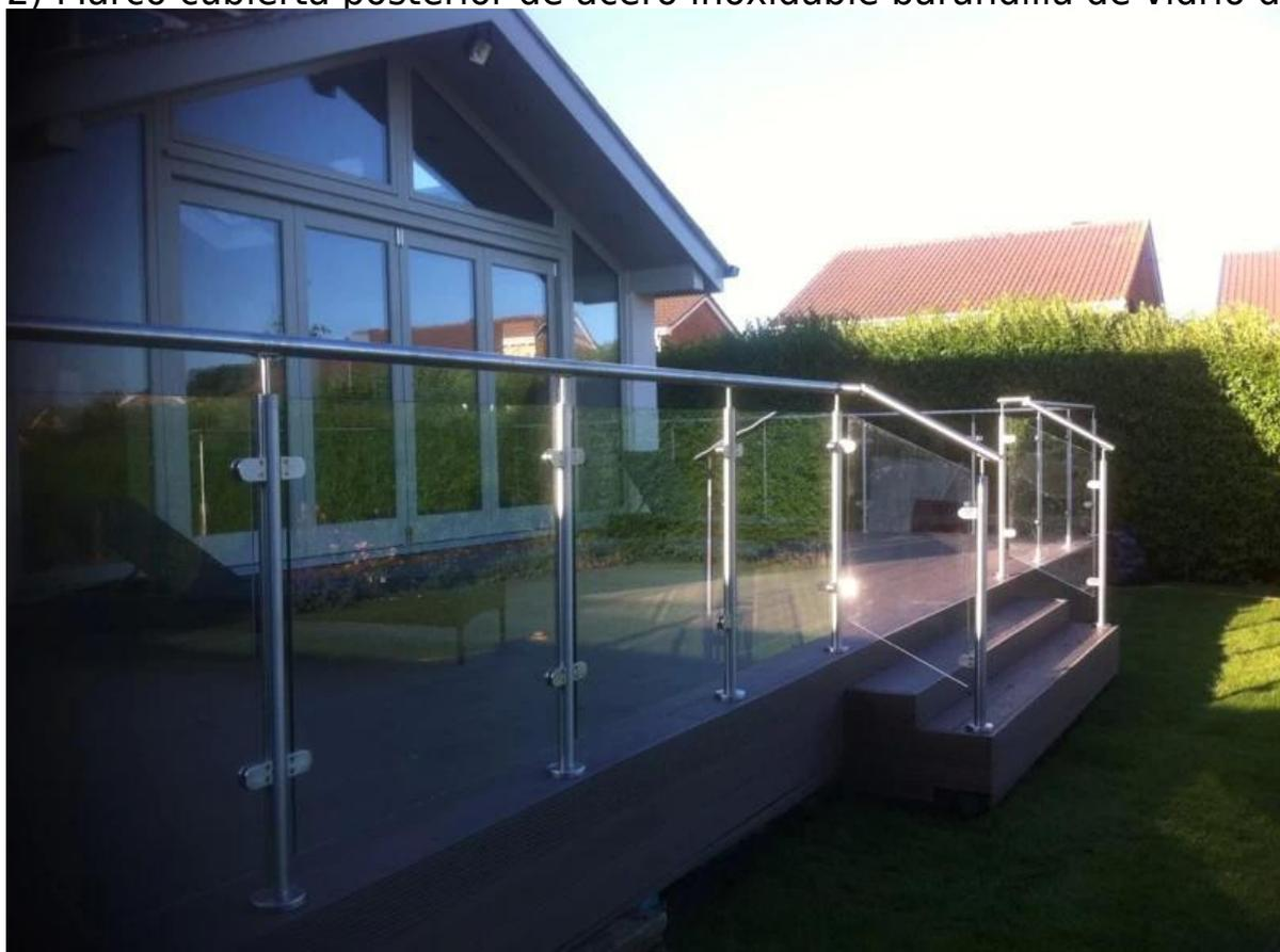
3) semi-marco cubierta posterior de acero inoxidable barandilla de vidrio de diseño,
