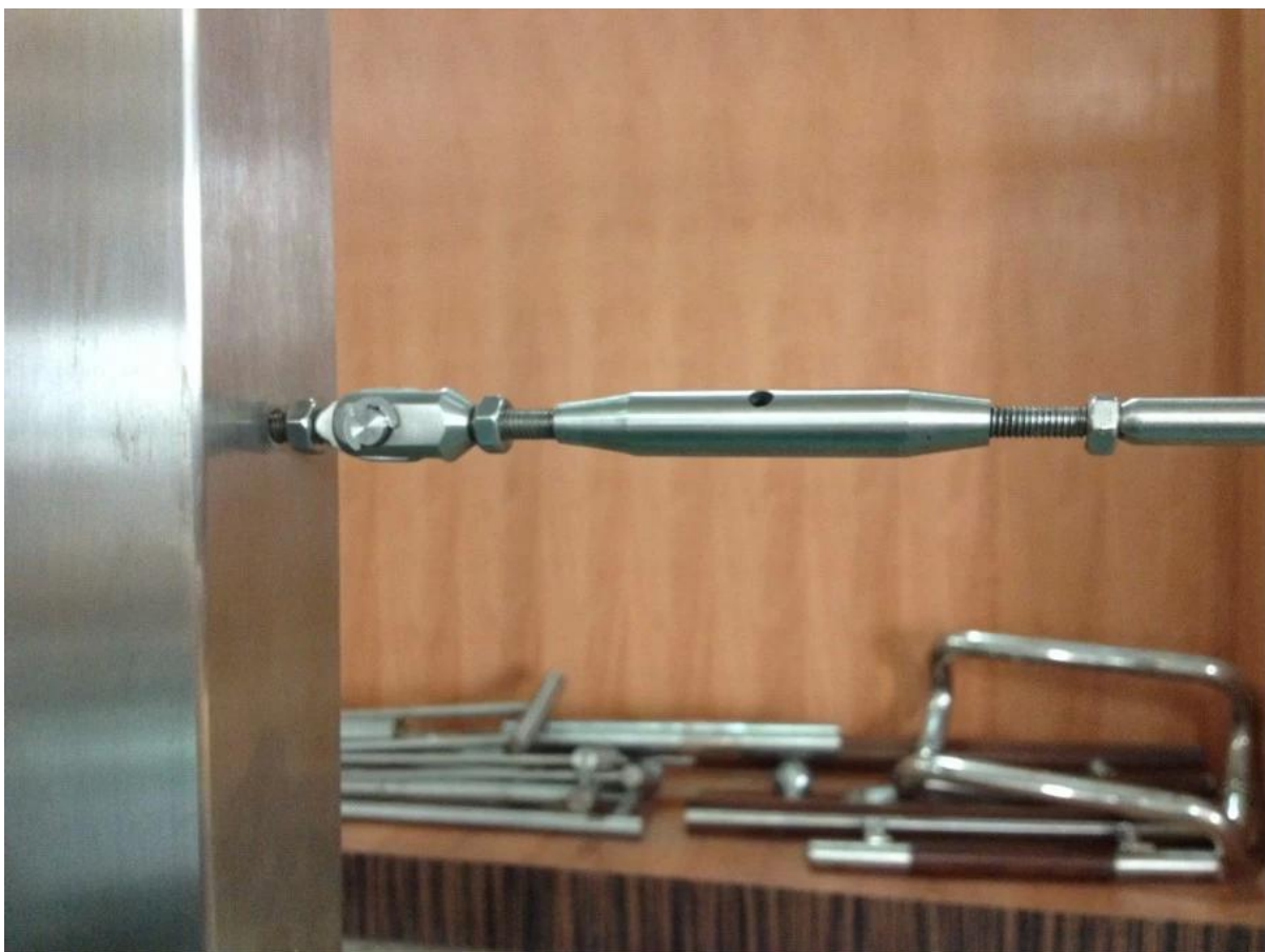
Tensor de cable T804 fijado al acero -
