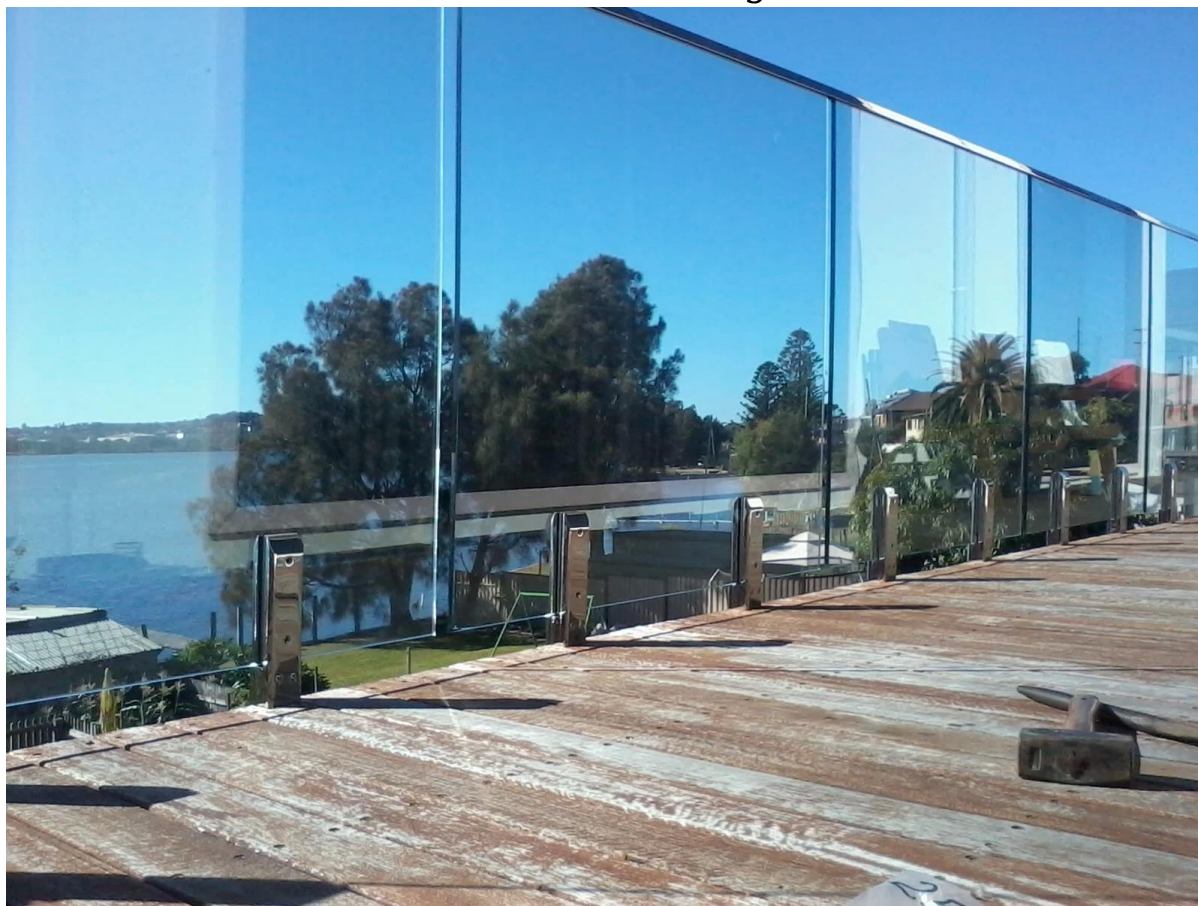
fotos de instalación de barandillas tragamonedas
