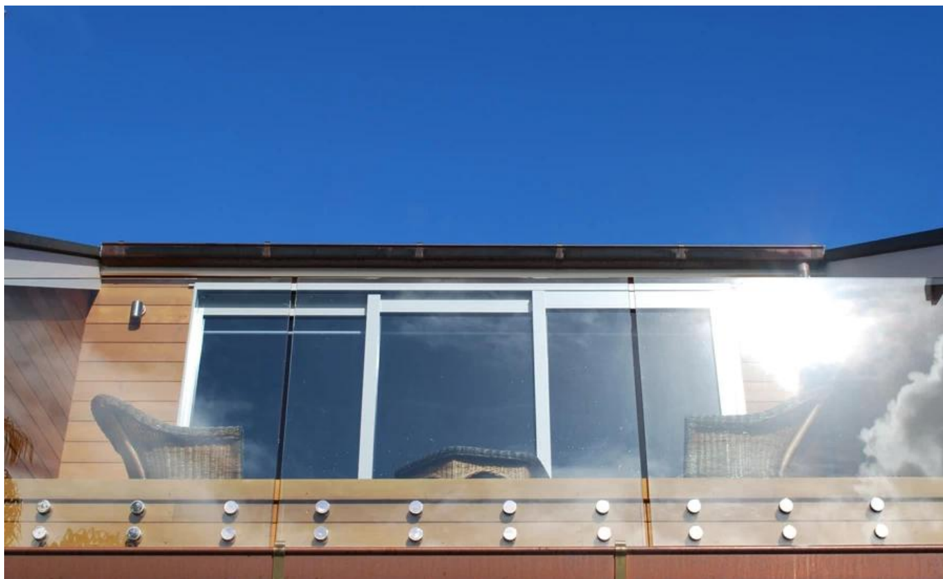
Fotos de instalación de barandillas de separación de vidrio
