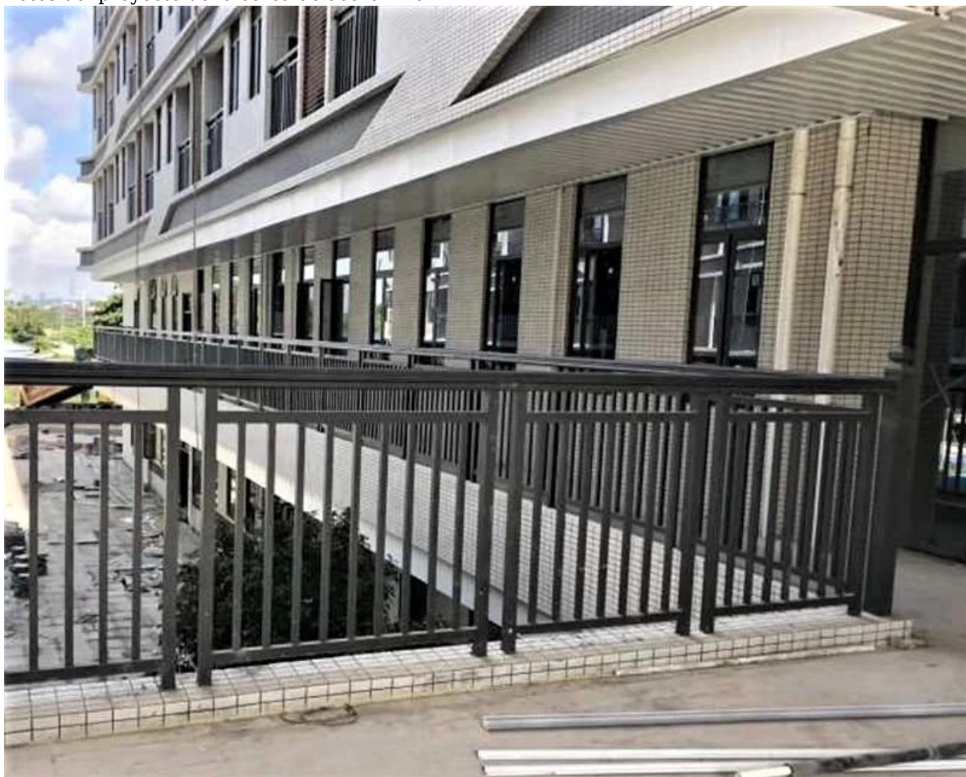
Fotos del proyecto de la cerca de acero zinc
