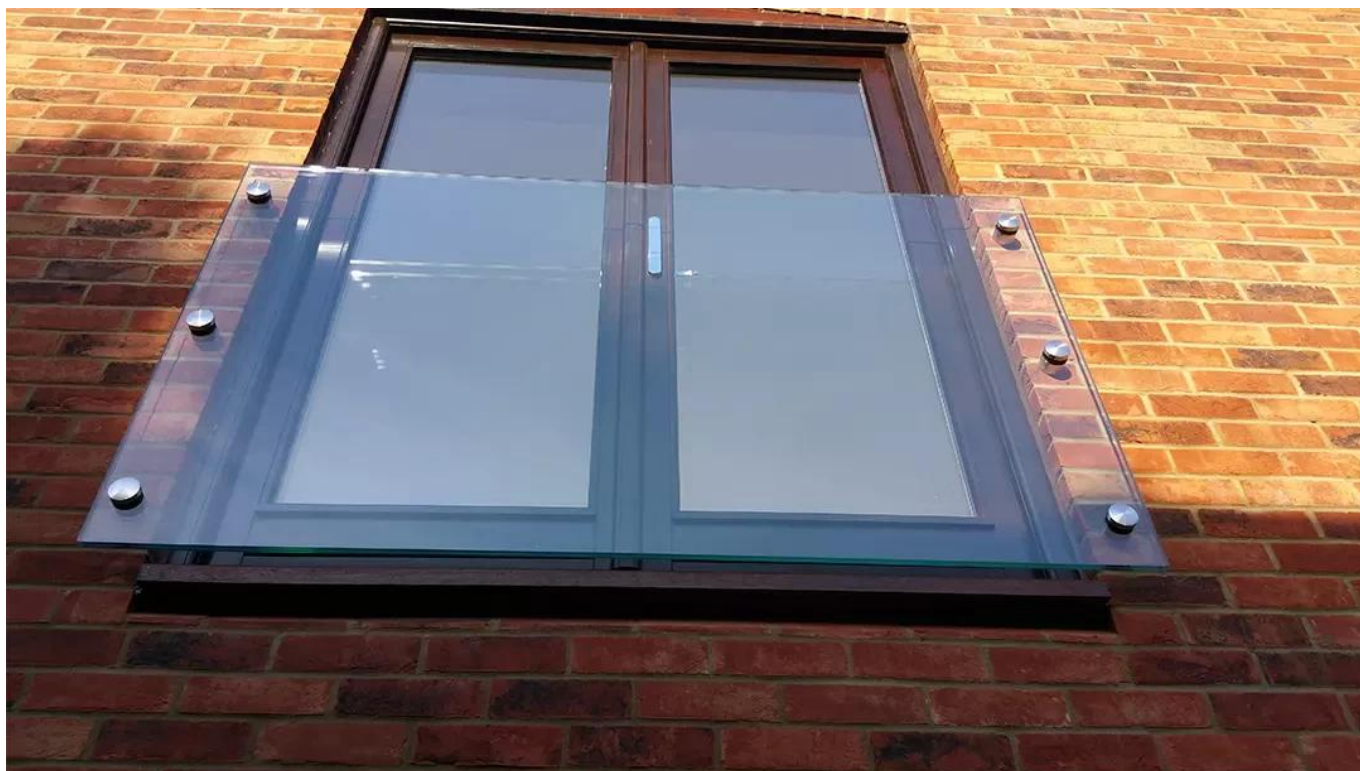
Fotografías de instalación de las barandas de vidrio.
