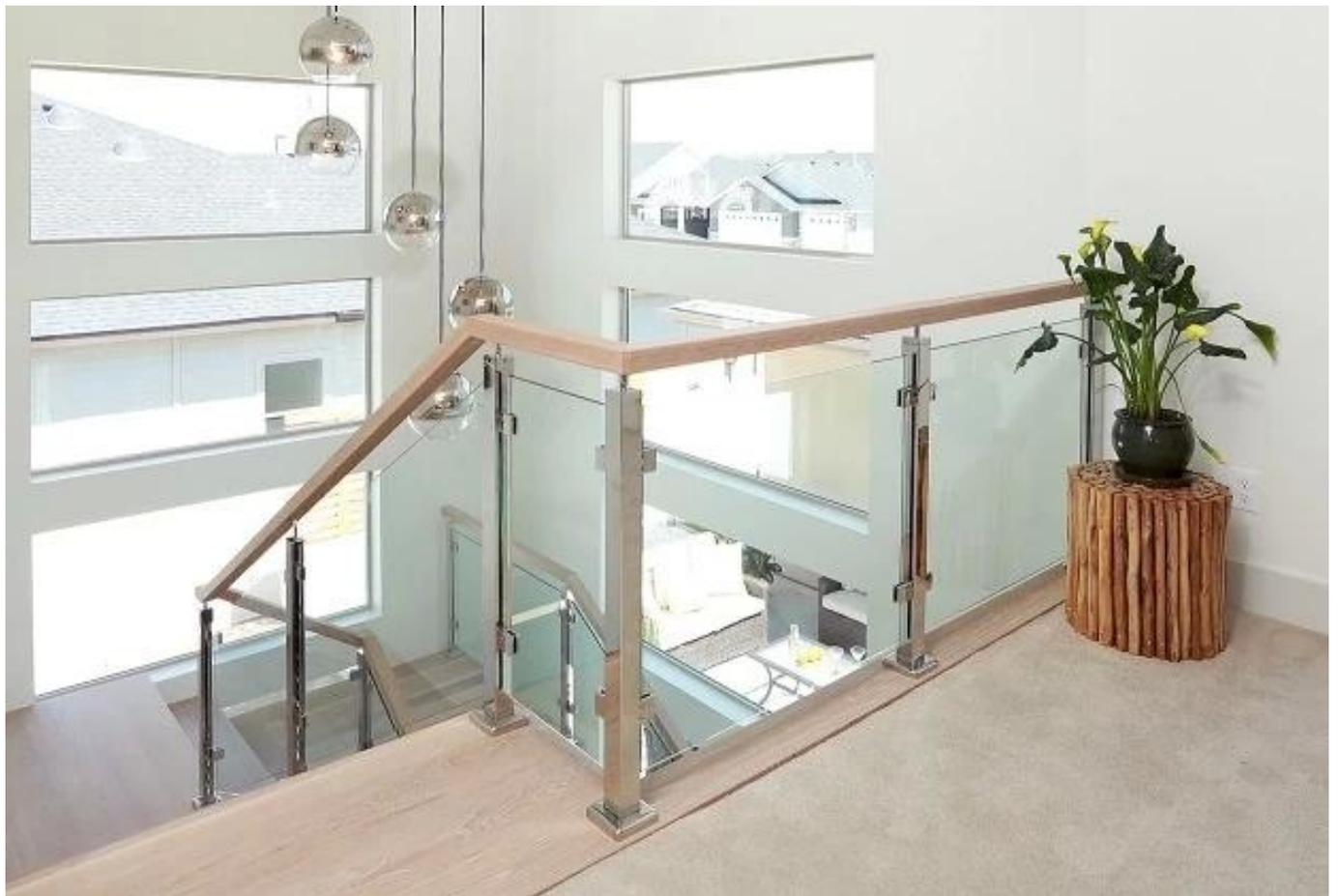
La abrazadera de barandilla de vidrio generalmente se usa con un poste de acero inoxidable para sujetar paneles de vidrio, para barandilla de balcón, barandilla de terraza, escalera. Apto tanto para interior como para exterior.
