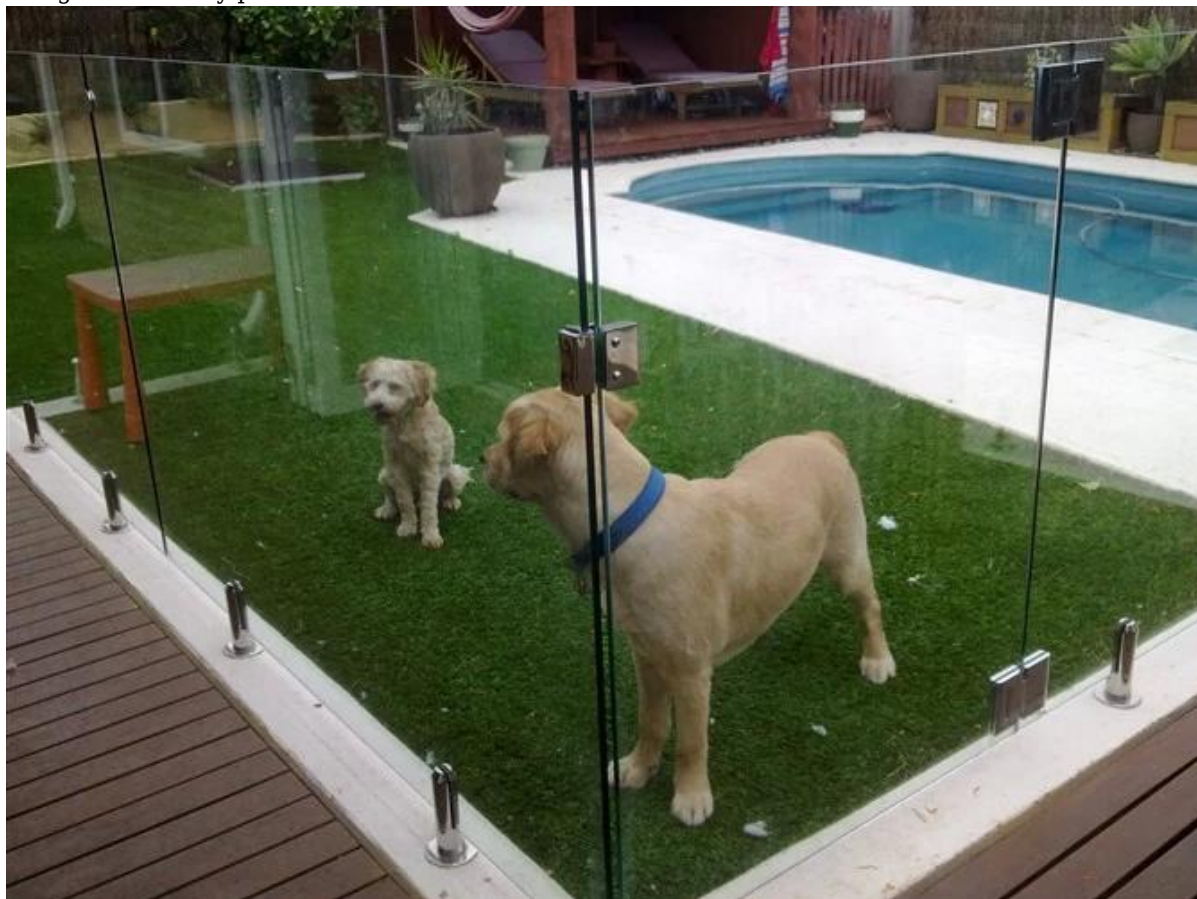
Accesorios relacionados con la espiga de cristal: Bisagra de vidrio y pestillo:
