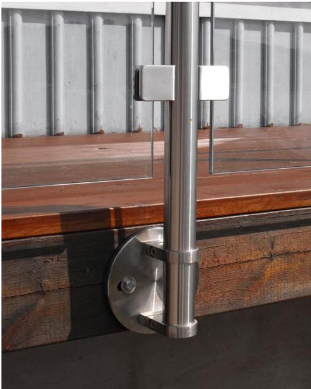
Laterales de acero inoxidable sistema de cable de alambre cuerda barandilla montada;
