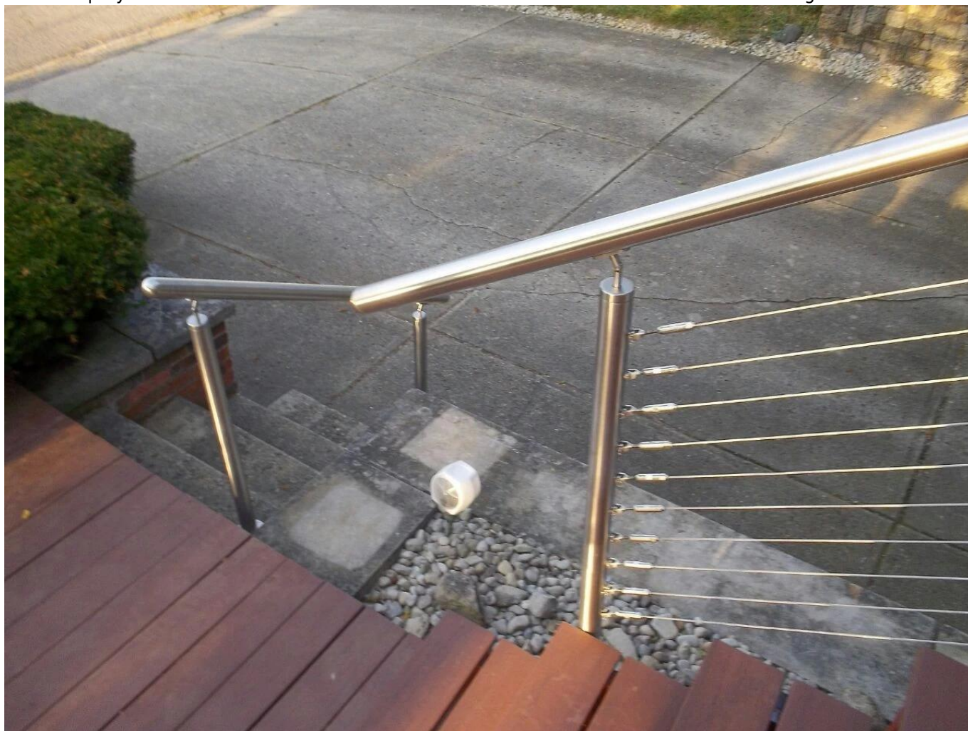
Fotos del proyecto de balaustradas de cable de acero con T803 Tensor de cable roscado Swageless-
