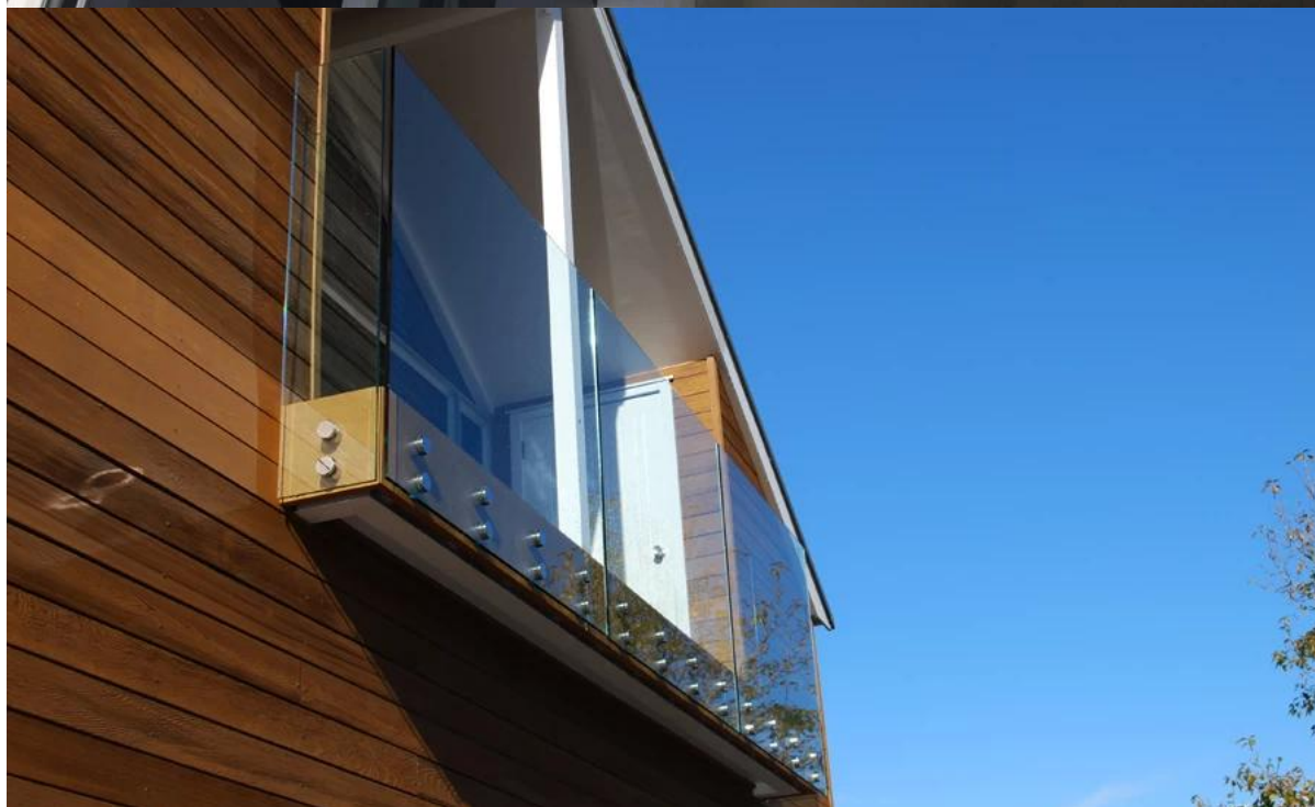
Pilar + barandilla superior
