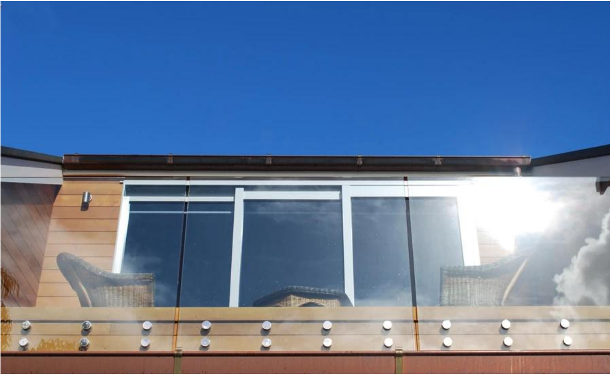
barandilla de escalera
