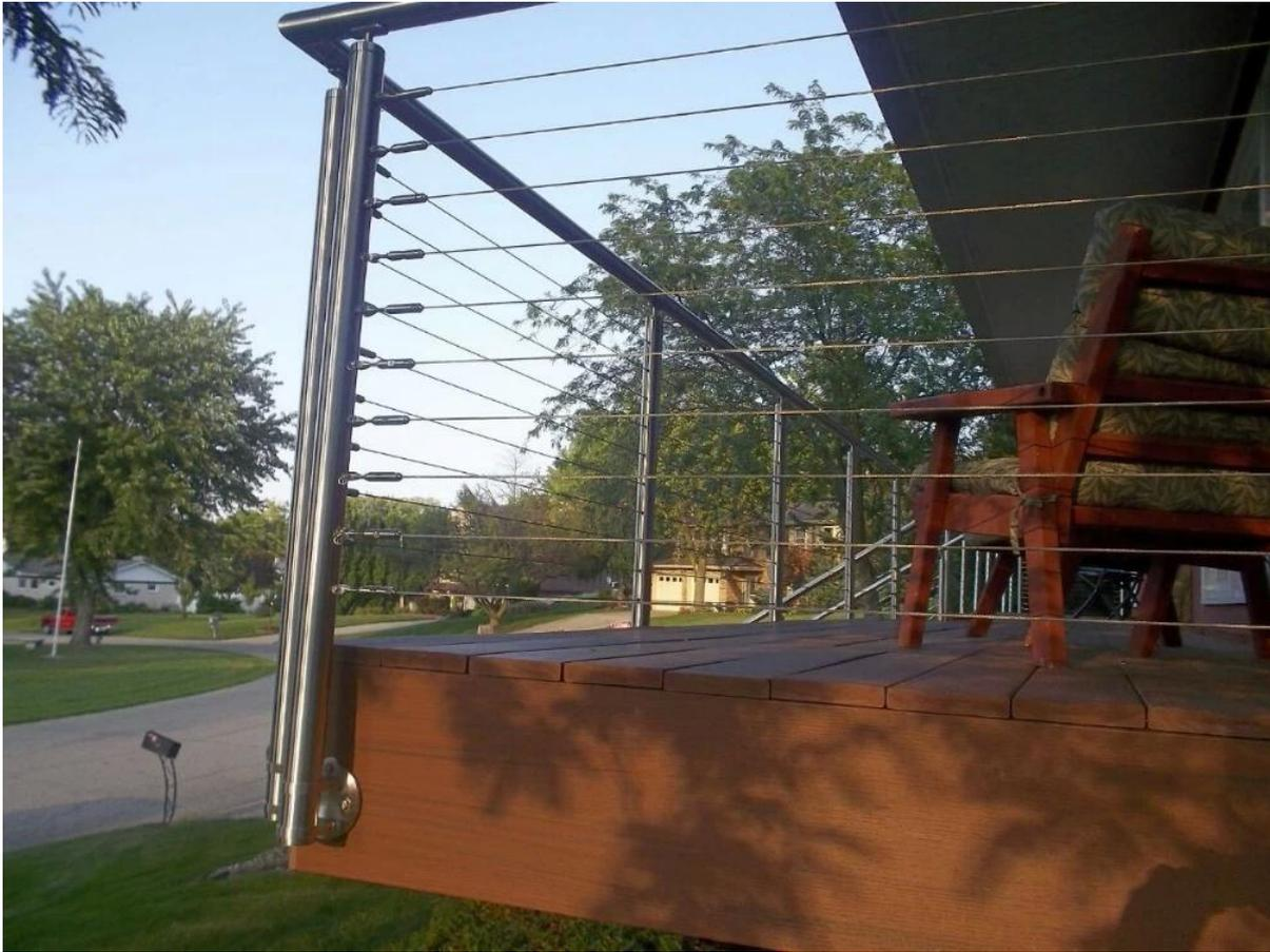
[proyecto de cable de acero inoxidable barandilla posterior 3. Forma cuadrada:](#) diseño de barandilla de cable de acero inoxidable para la cubierta al aire libre,
