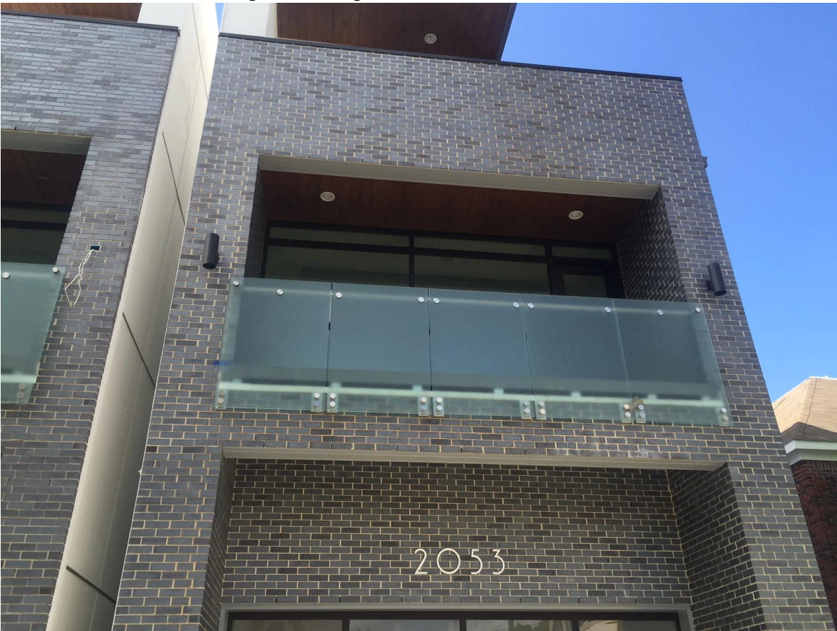
Fotos de instalación del soporte de separación de la barandilla de cristal
