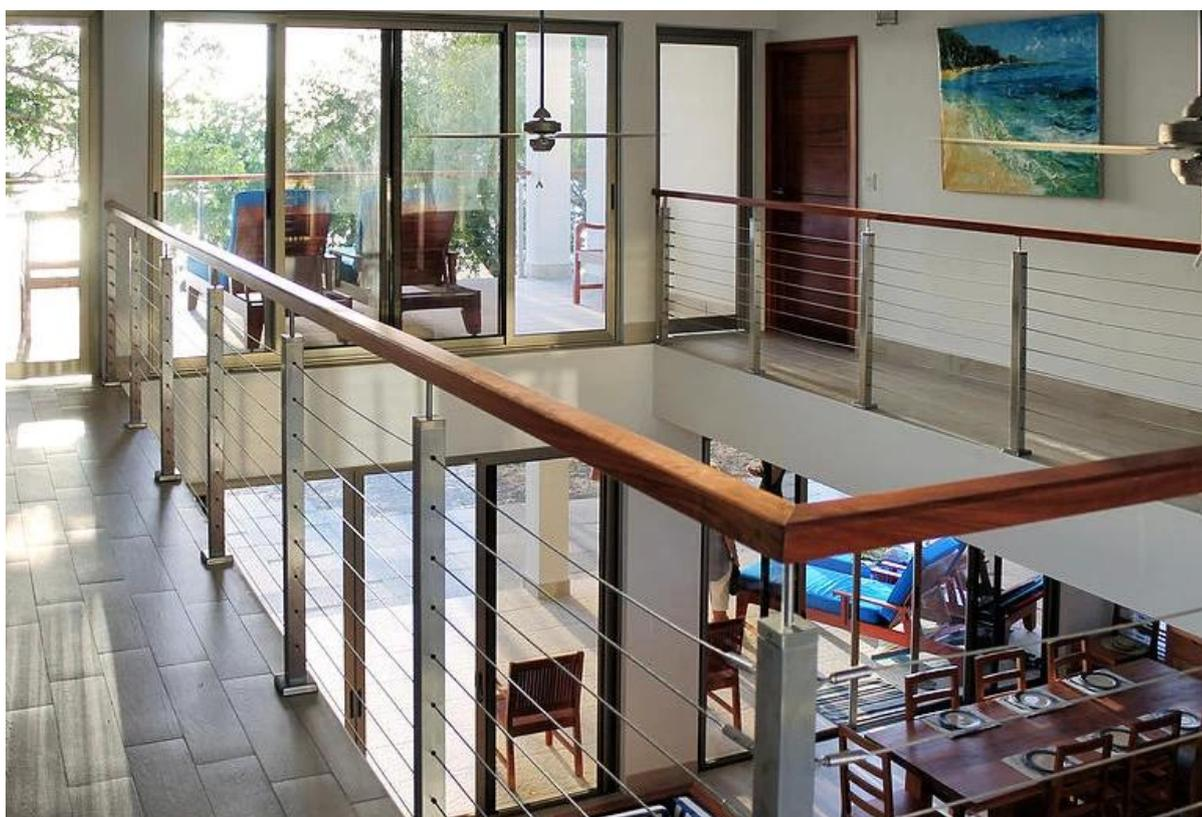
Foto del sistema ferroviario cable de montaje lateral con pasamanos superior de acero inoxidable:
