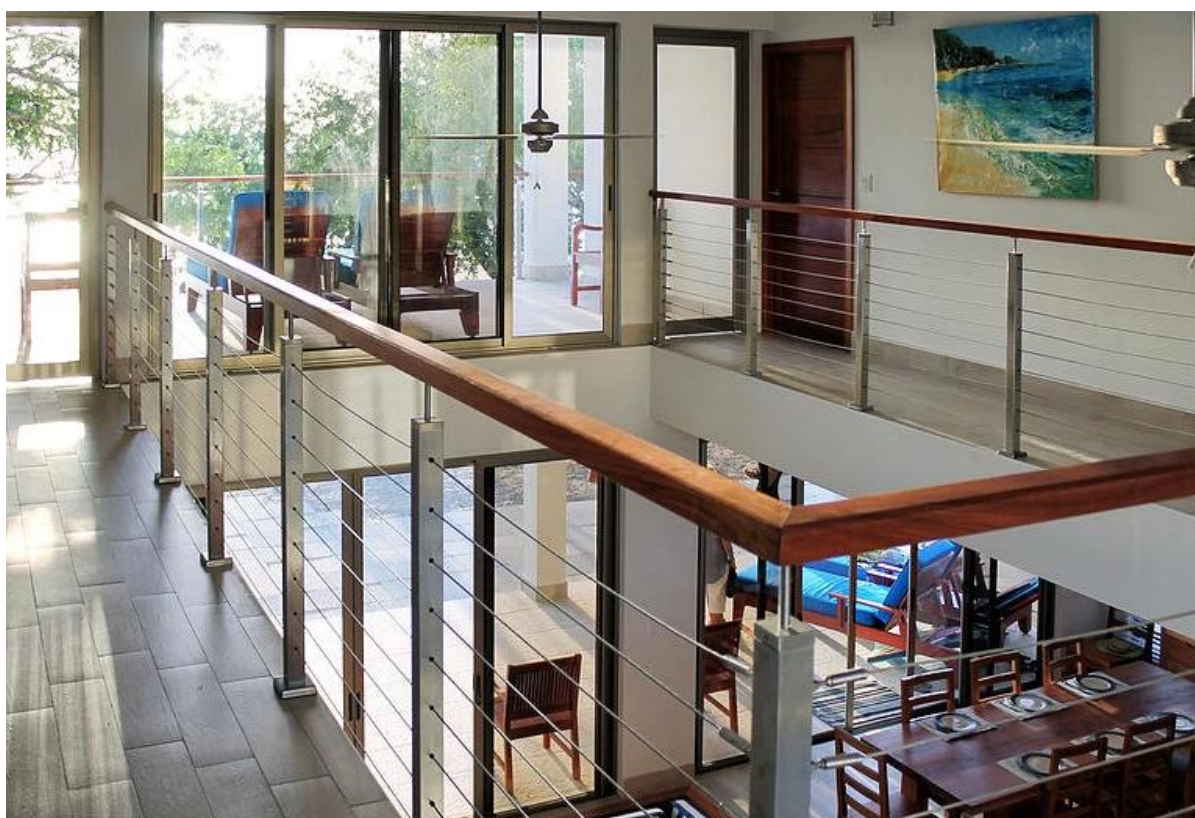
Imagen de barandilla cable, barandilla interior con pasamanos de madera arriba:
