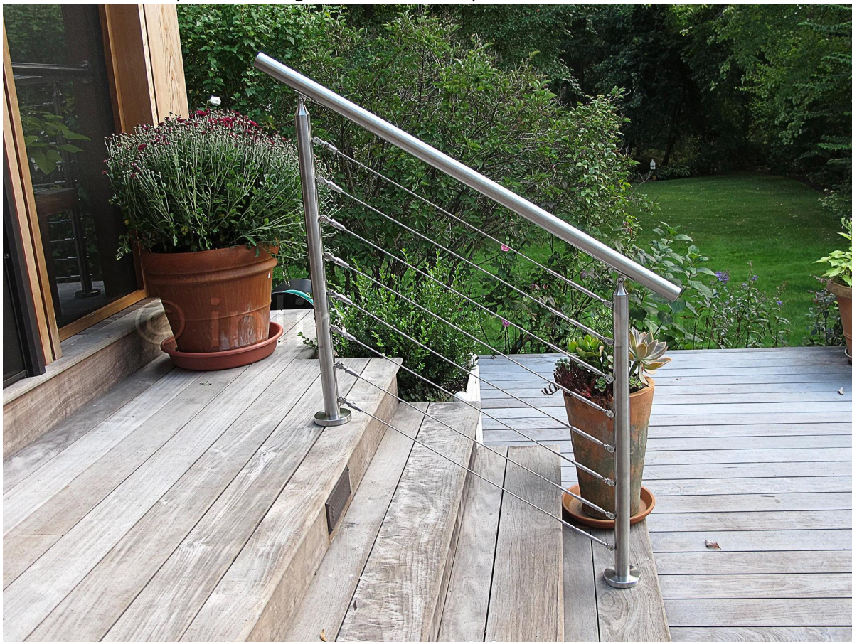
barandilla de cable para escalera interior
