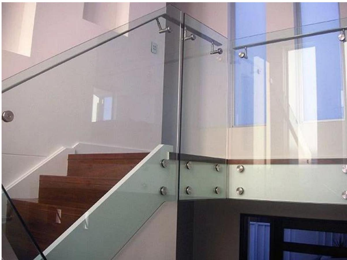
3) de acero .Stainless el montaje de paneles de vidrio soportes pasillo interior barandilla de vidrio de diseño
