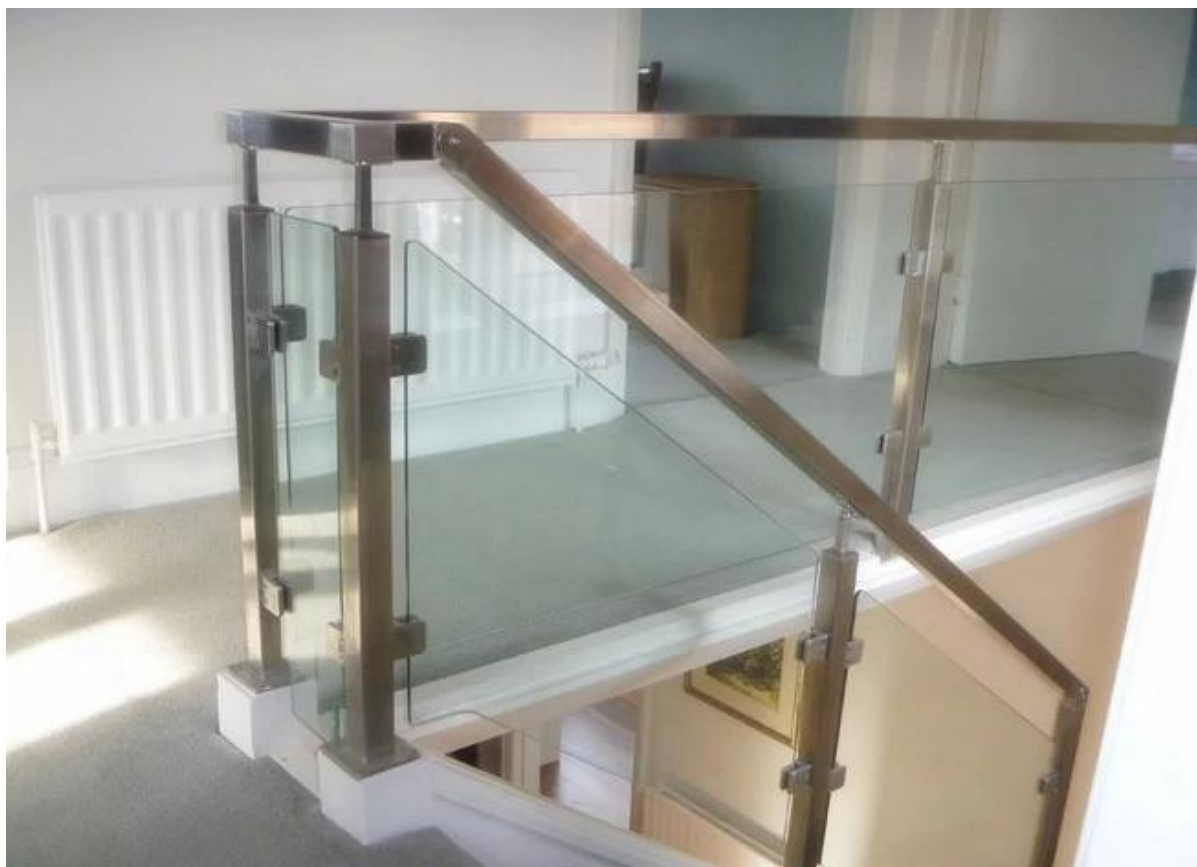
barandilla de acero inoxidable, cubierta posterior redonda, barandilla de metal de vidrio para los pasos
