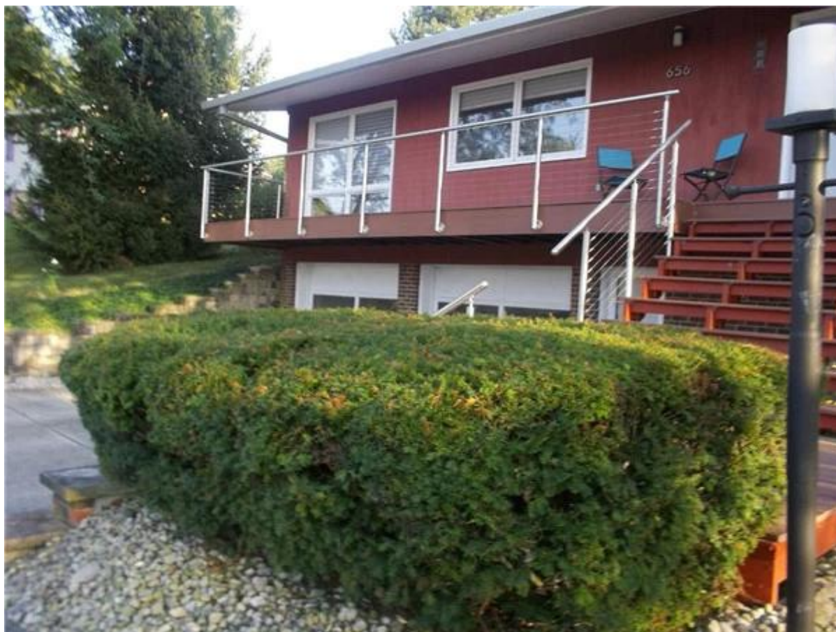
2. Fotos de postes de barandillas de cables de acero-
