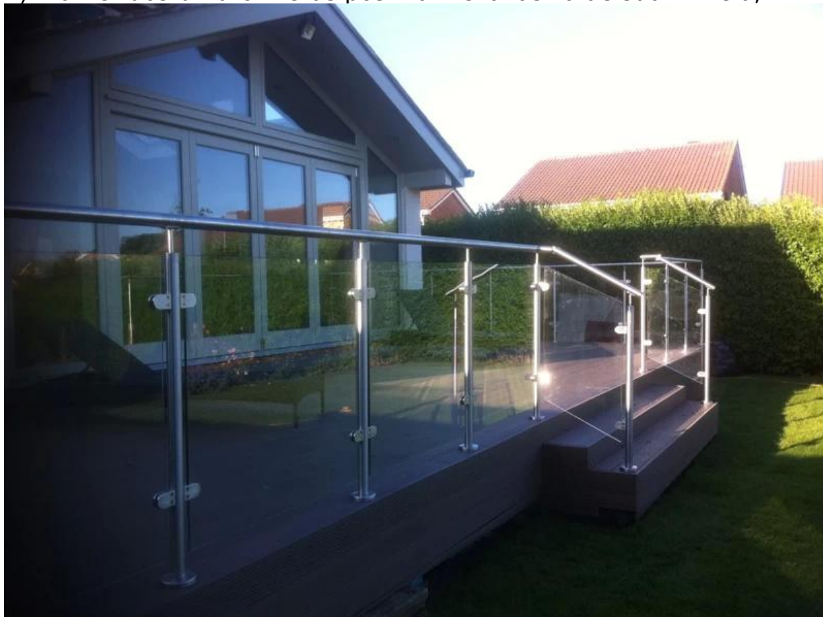
3) Semi-frame ruostumaton teräs post kannella lasikaide suunnittelu,
