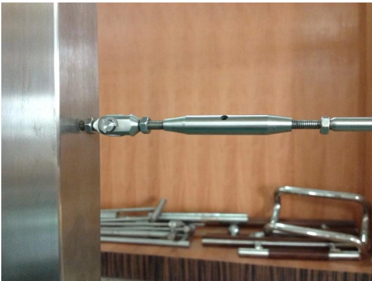
T804 vaijerikiristin kiinnitetty teräkseen -
