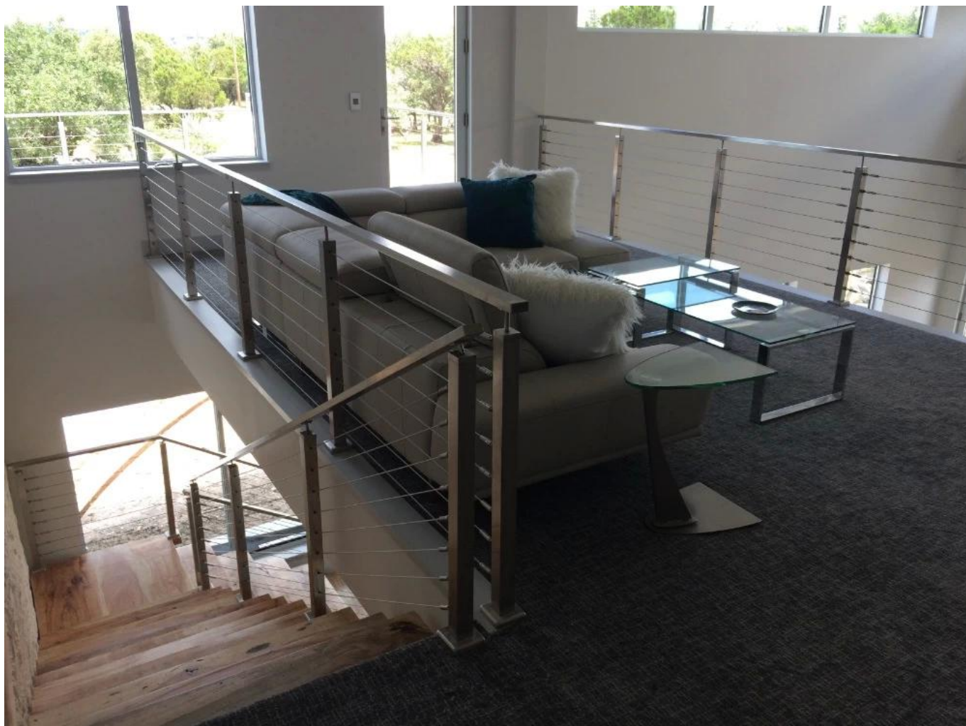
Kaapelilla täytetty ruostumattomasta teräksestä valmistettu kaidepylväs puisella kaiteella malliportaiden kaiteiden suunnitteluun
