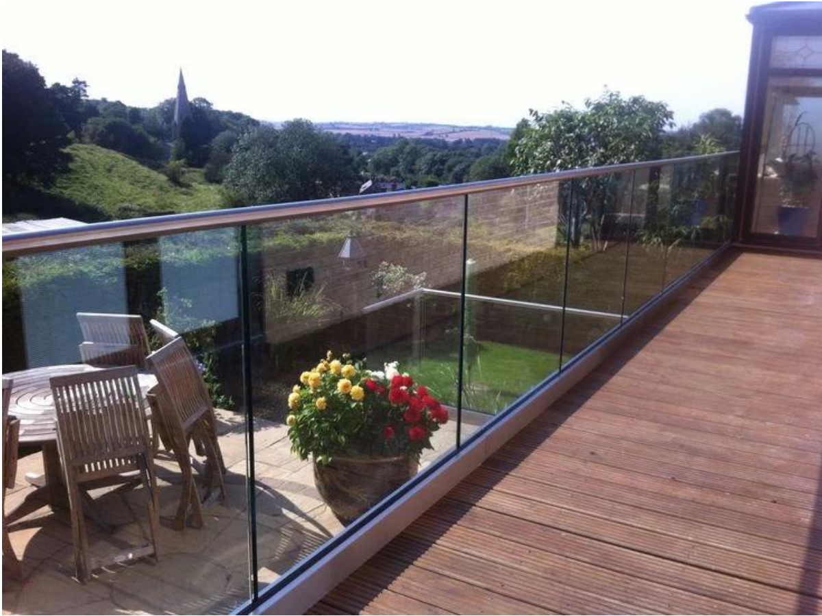
Alumiini U kanava + 10-12mm karkaistu lasi rakenne
