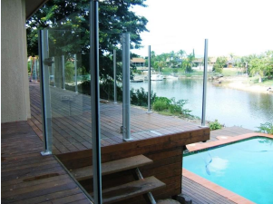
Alumiini lasi kaide on parvekke ja terassi aidat
