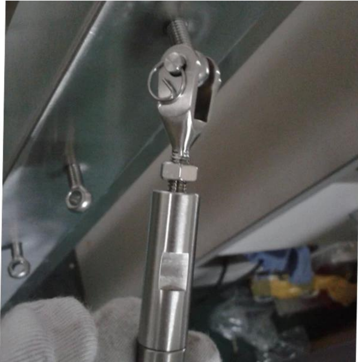
4.project pic vaijerilla kaiteen järjestelmä sisä rappu ruostumatonta terästä nelion kaide
