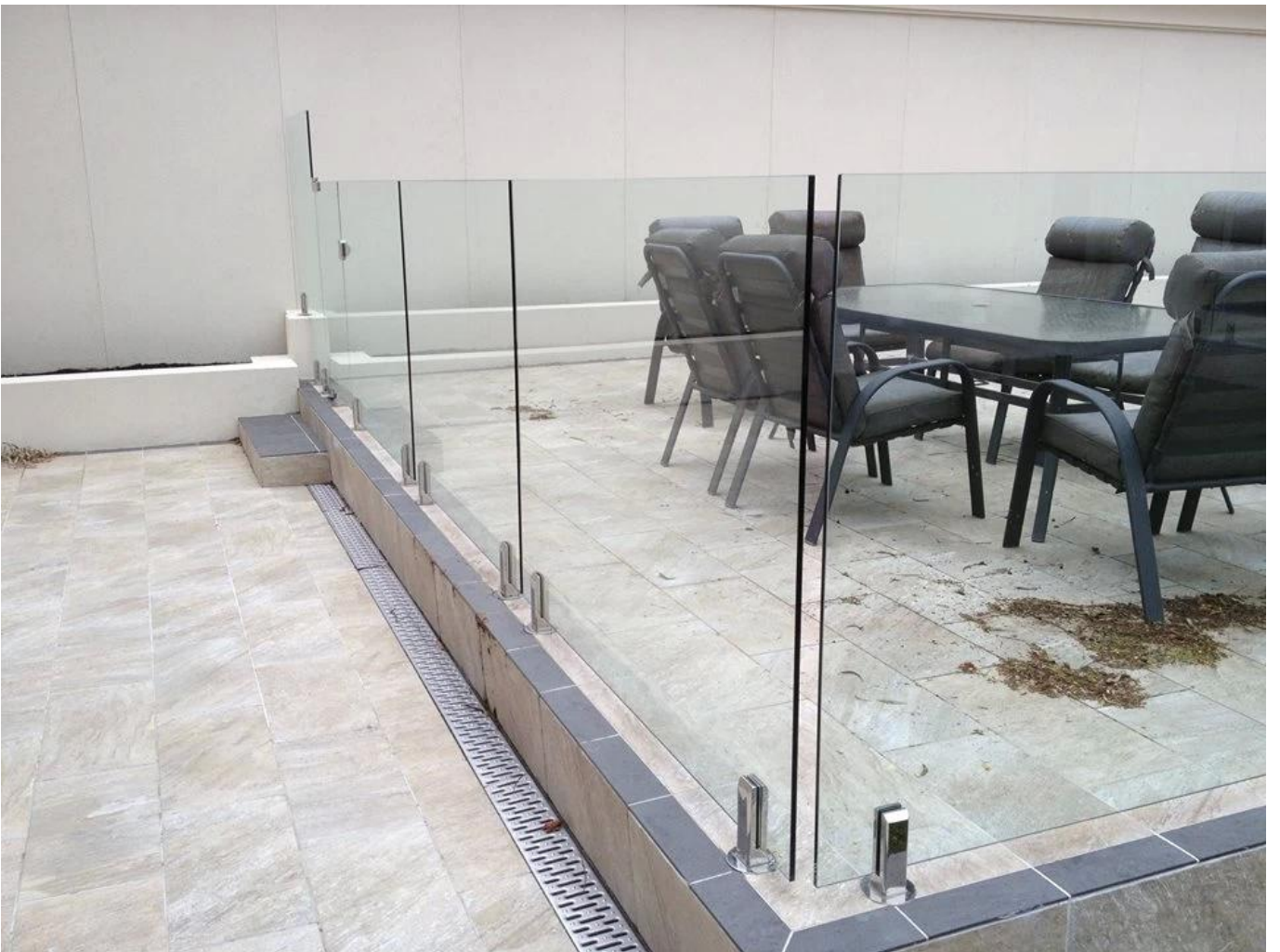
asennus kuva kaiteet
